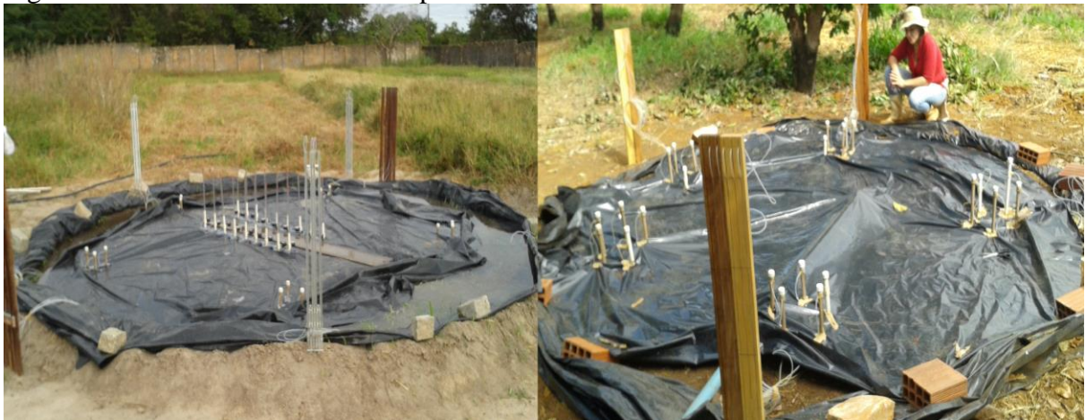
Figura 6 – Perfis cobertos com lona plástica.
