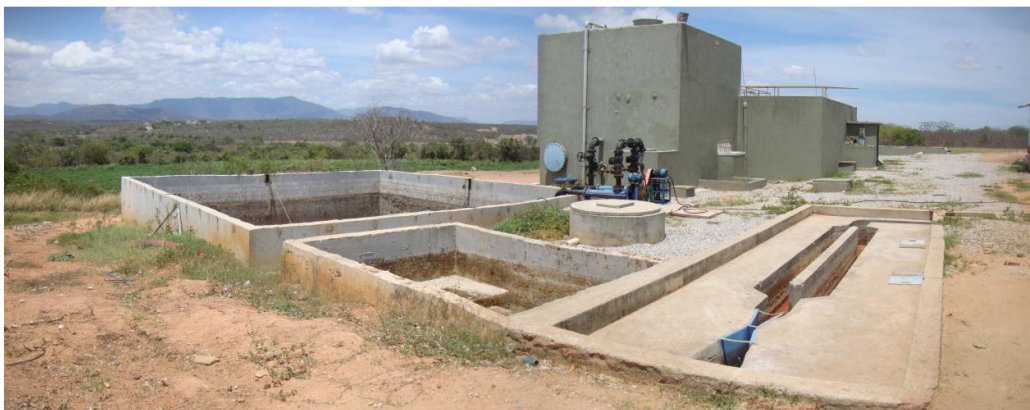
Figura 2 - Estação de Tratamento de Efluentes, Aquiraz - CE.
