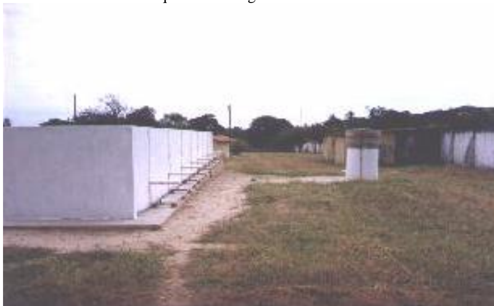
Figura 1 - Modelo físico dos tanques de drenagem.
