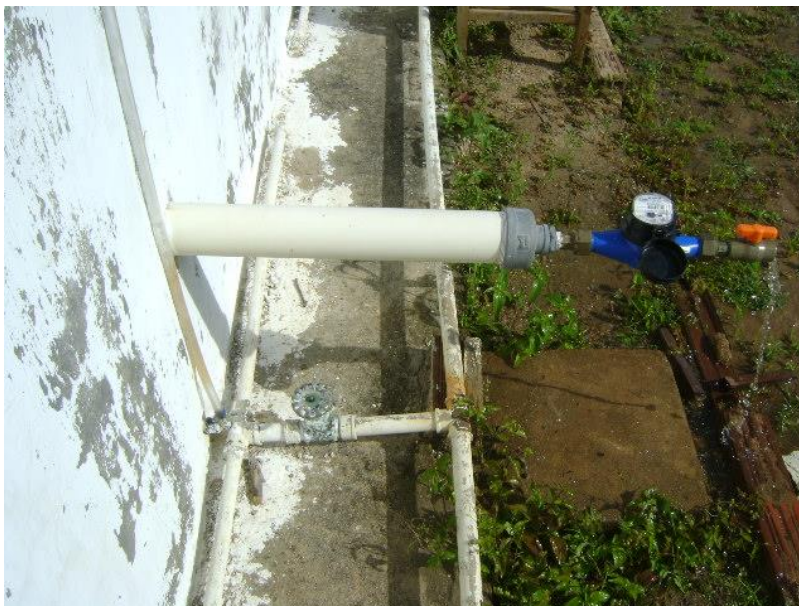
Figura 2 - Piezômetro e hidrômetro.
